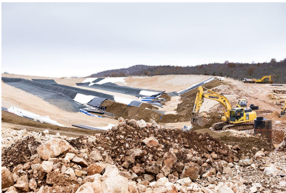
Slika 10. Centar za gospodarenje otpadom – Kladnjice, Lećevica (Faza izgradnje, 2022.)
